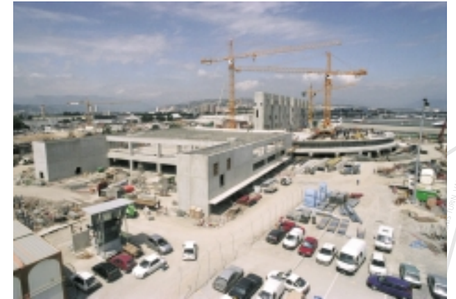
Ci-dessus : Travaux d'extension du Terminal 2
